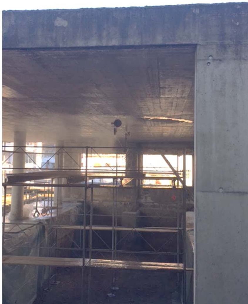
Sicht auf das Gerüst unter der geplanten Öffnung
