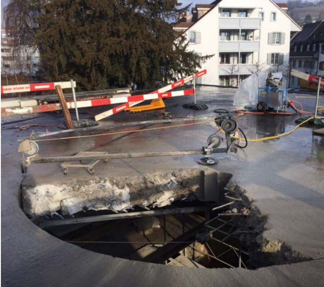
Kreisseilsäge welche mit dem Kettenzug vorangezogen wird
