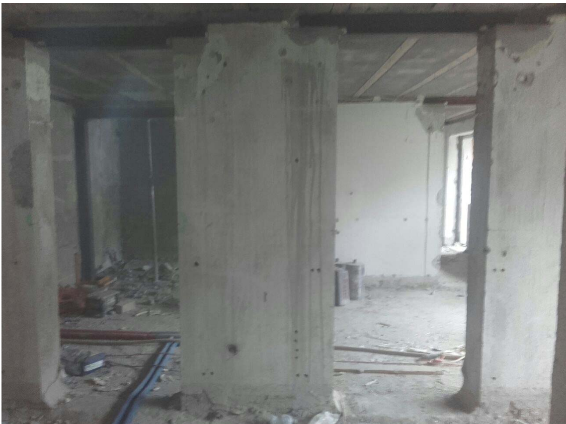
Neue Wanddurchbrüche mit eingebauten Stützen
