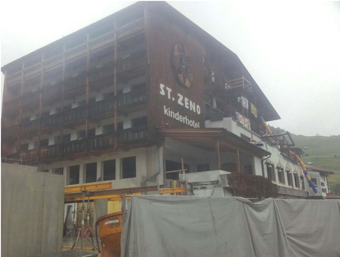
Aussenansicht über den laufenden Umbau
