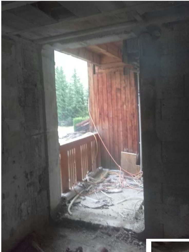
Neue Öffnung für Balkontüre
