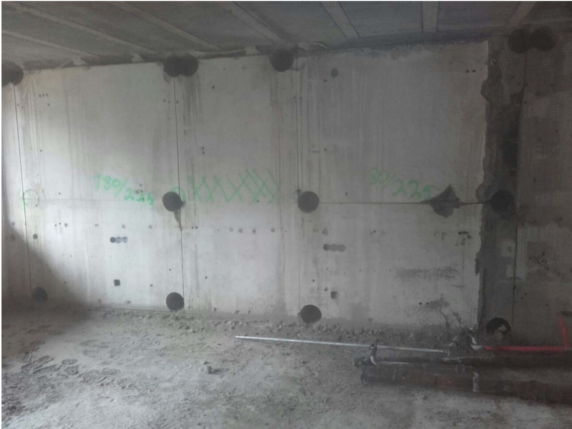
Eckbohrungen (kein Überschneiden) und Sturzauflager
