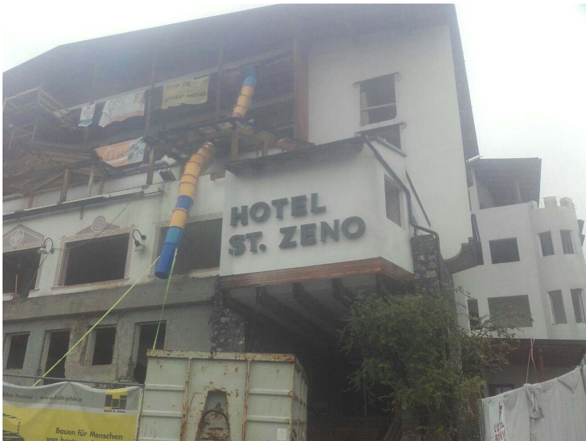
Aussenansicht über den laufenden Umbau
